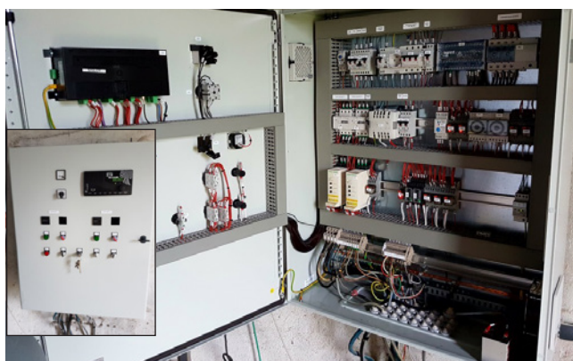
Remplacement de l'armoire électrique du château d'eau.
